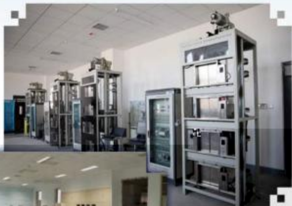
智能电梯安装调试 维护训练场所
